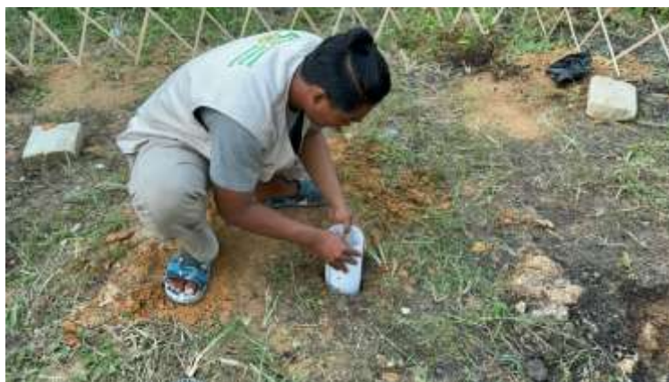
Gambar 3 Pembuatan Lubang Resapan Biopori
