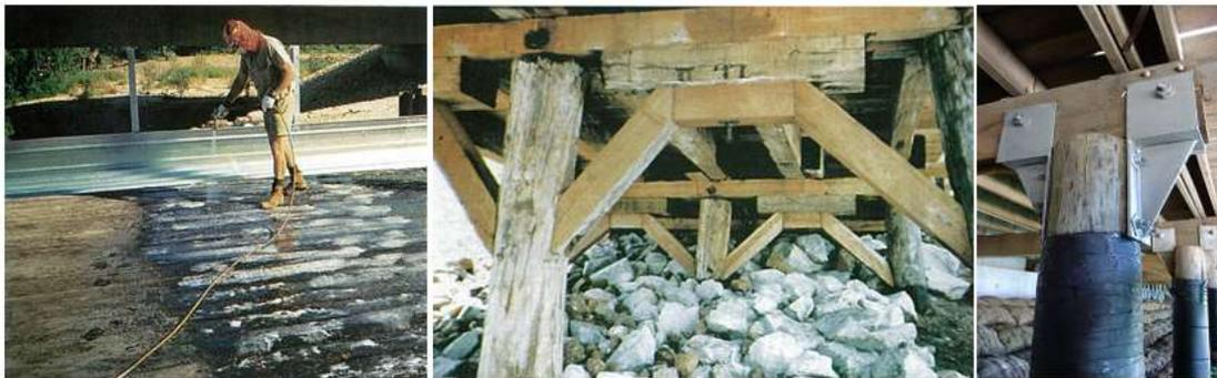
Gambar 9 Pemeliharaan Dan Perbaikan Jembatan Kayu. A) Penyemprotan Pengawet Kayu. B) Perkuatan Sambungan Antara Balok Dan Tiang. C) Pelapisan Tiang Kayu Yang Berada Di Daerah Pasang Surut
