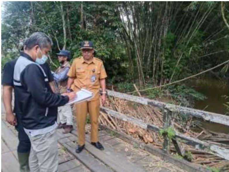
Gambar 1 Kondisi Jembatan Kayu, Yang Lantai Dan Gelagarnya Memerlukan Perbaikan, Di Kecamatan Samboja
