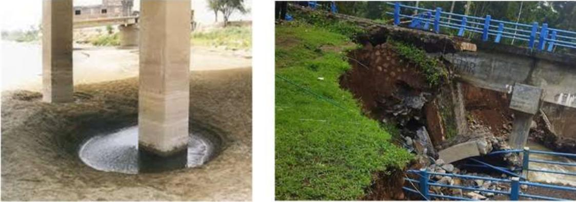
Gambar 7 Kerusakan Jembatan Akibat Scouring Di Sekitar Pilar Dan Kepala Jembatan
