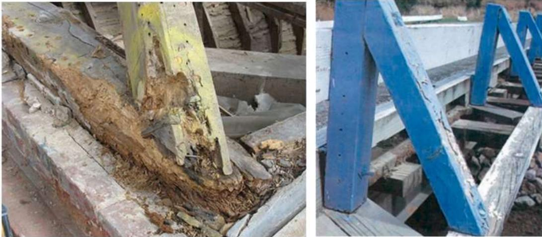
Gambar 4 Kerusakan Jembatan Kayu Akibat Faktor Lingkungan. A) Pelapukan Akibat Jamur Dan Mikroorganisme. B) Permukaan Kayu Retak-Retak Halus Akibat Radiasi Sinar Matahari
