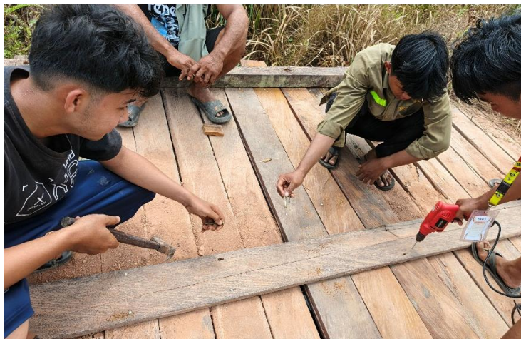
Gambar 4 Pemasangan Ulang Elemen Lantai Jembatan Kayu yang Mengalami Pelonggaran
