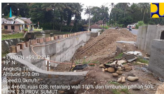
Gambar 1.1 dinding penahan tanah tipe kantilever (Sumber : Pelaksanaan 2021)
