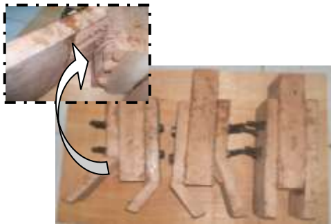
Gambar 7. Model Kerusakan Sambungan Kayu Keruing
