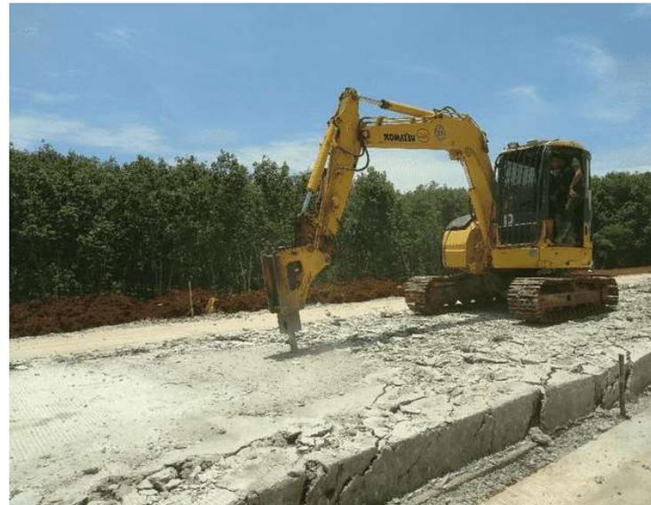
Gambar 5 Pekerjaan Pembongkaran Lapisan
