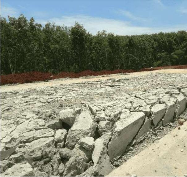
Gambar 6 Pekerjaan Pembongkaran Lapisan
