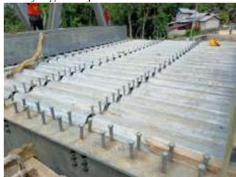
**Gambar 1.** Konstruksi Lantai Jembatan Yang Di Tinjau
