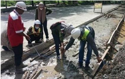
**Gambar 13.** Pengukuran Tebal Pada Bahu Jalan
