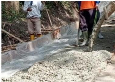
**Gambar 14.** Penuangan Beton
