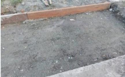
**Gambar 7.** Hasil Pemadatan Agregat
