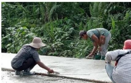
**Gambar 15.** Perataan Permukaan Beton
