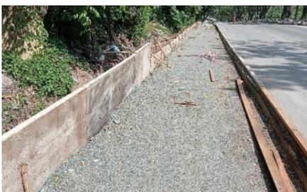
**Gambar 9.** Pemasangan Bekisting
