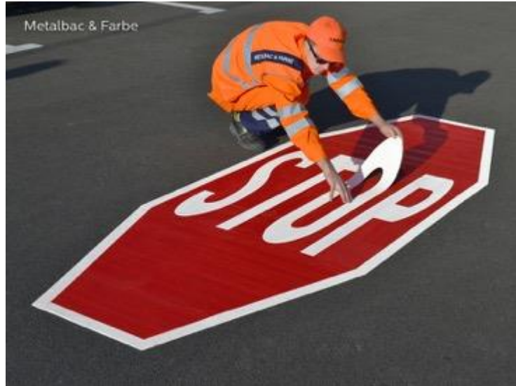
Gambar 1. Pemasangan marka termoplastik pre-formed (Metalbac & Farbe, 2020)
