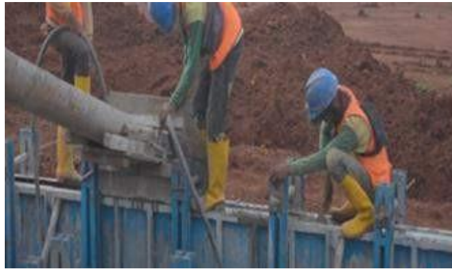
Gambar 17. Pengecoran dinding U-Ditch
