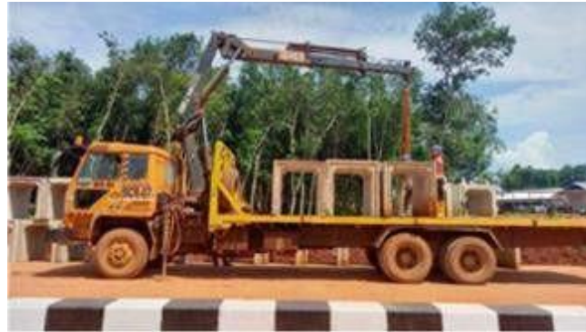
Gambar 7. Instalasi U-Ditch dengan mounted crane truck
