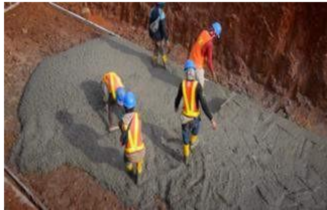
Gambar 13. Pengecoran lantai kerja
