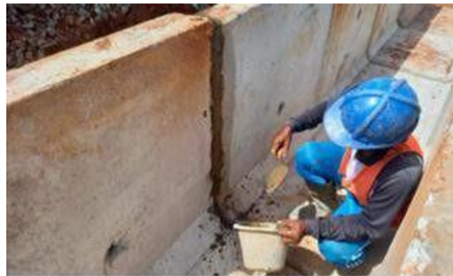
Gambar 8. Finishing sambungan dengan acian mortar
