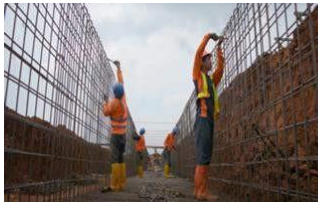
Gambar 14. Pembesian U-Ditch
