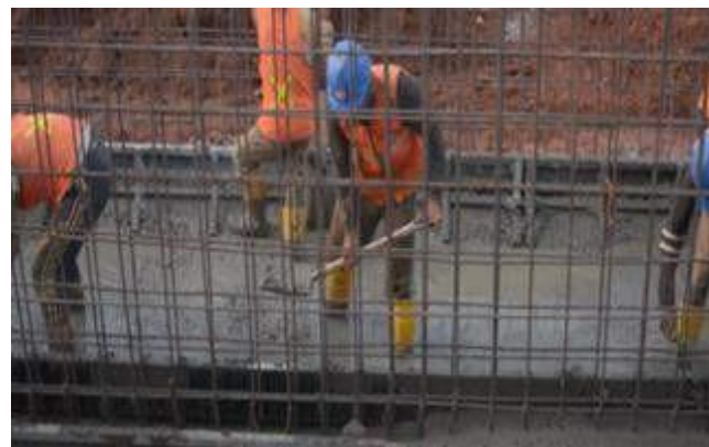
Gambar 15. Pengecoran bottom slab
