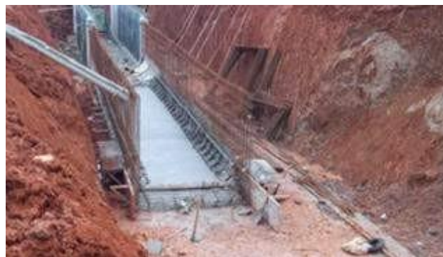
Gambar 11. Pemasangan bekisting bottom slab
