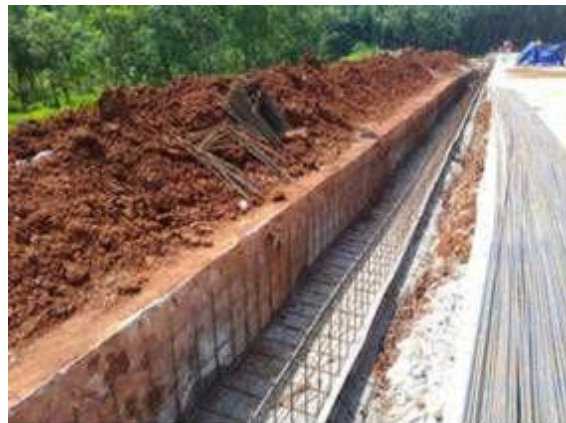
Gambar 10. Pembesian bottom dan wall sebatas chamfer bawah
