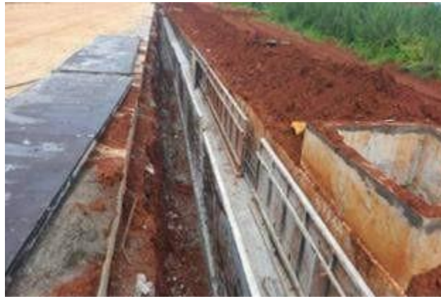
Gambar 12. Pembesian dinding saluran dan pemasangan bekisting
