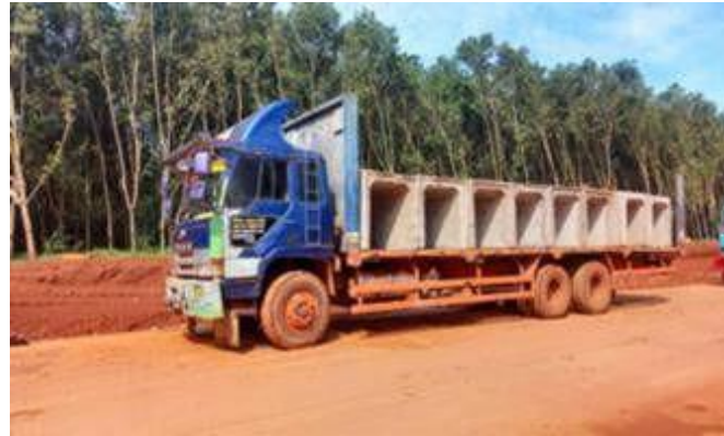
Gambar 5. Pengiriman U-Ditch ke lokasi pekerjaan
