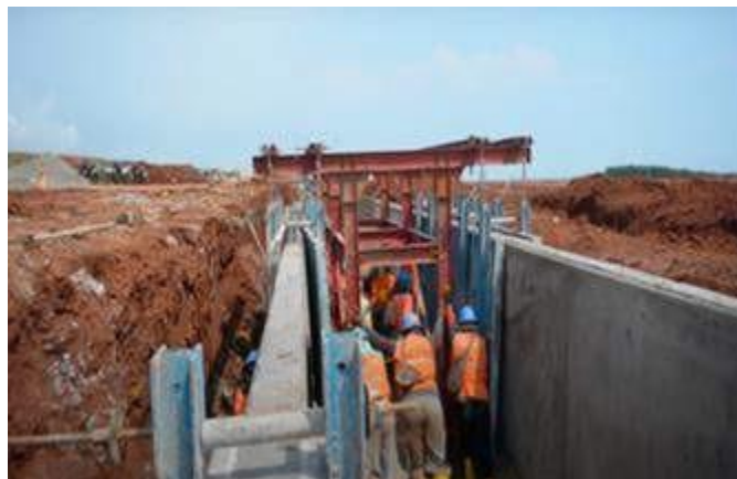
Gambar 18. Penggeseran sliding formwork ke lokasi saluran selanjutnya
