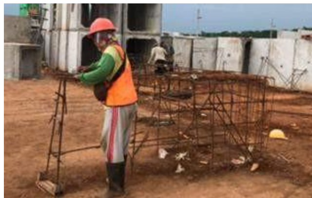
Gambar 4. Fabrikasi U-Ditch
