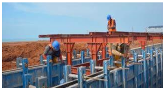
Gambar 16. Pemasangan bekisting dinding menggunakan Sliding Formwork
