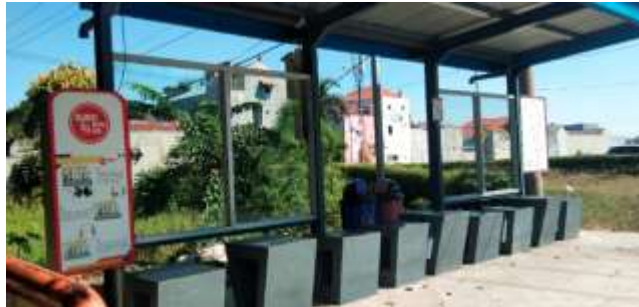
Gambar 1. Halte Bis Suroboyo di bundaran kampus ITS
