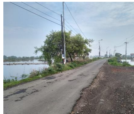
Gambar 2: Jalan Aspal (Sumber : Data Pribadi 2021)
