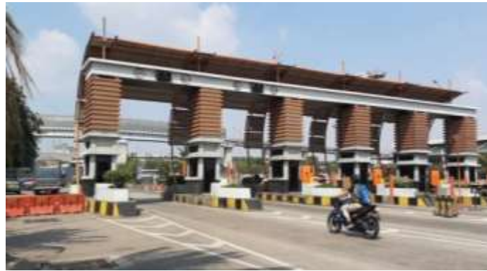
Gambar 3. 4. Kondisi eksisting Gerbang 9
