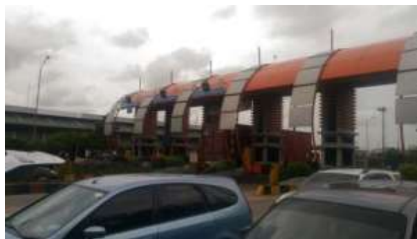
Gambar 3. 5 Kondisi eksisting Gerbang 9 dari depan
