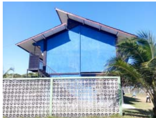
Gambar 4: Atap setengah pelana pada wisma kilang pertamina, Balikpapan Sumber: Dokumentasi penulis, Juni 2015
