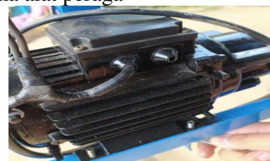
Gambar6 Pemasangan motor penggerak
